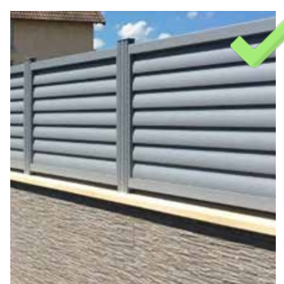
Mur bahut et dispositif à claire-voie
